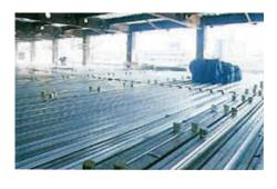
セルラダクトとは、コンクリート打設用の型枠として用いられる デッキプレートの下面の溝に鉄板を張り、できた空間を配線ダクト として利用したもの。拡張性に優れフロアダクトに比べて床面を 薄くできます。 点検の有無は問いません。
